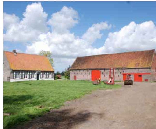
Uiterst gaaf bewaarde, 19e-eeuwse hoevesite. Hoevewoning met dwarsschuur en dubbel wagenkot, Beernem.
